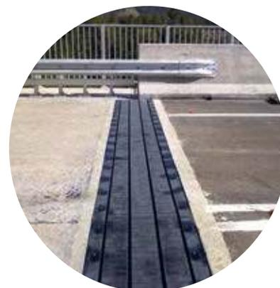
**Figura 1.80** Para evitar que algunos puentes se deformen o se rompan, se colocan separaciones entre los bloques que los conforman.
