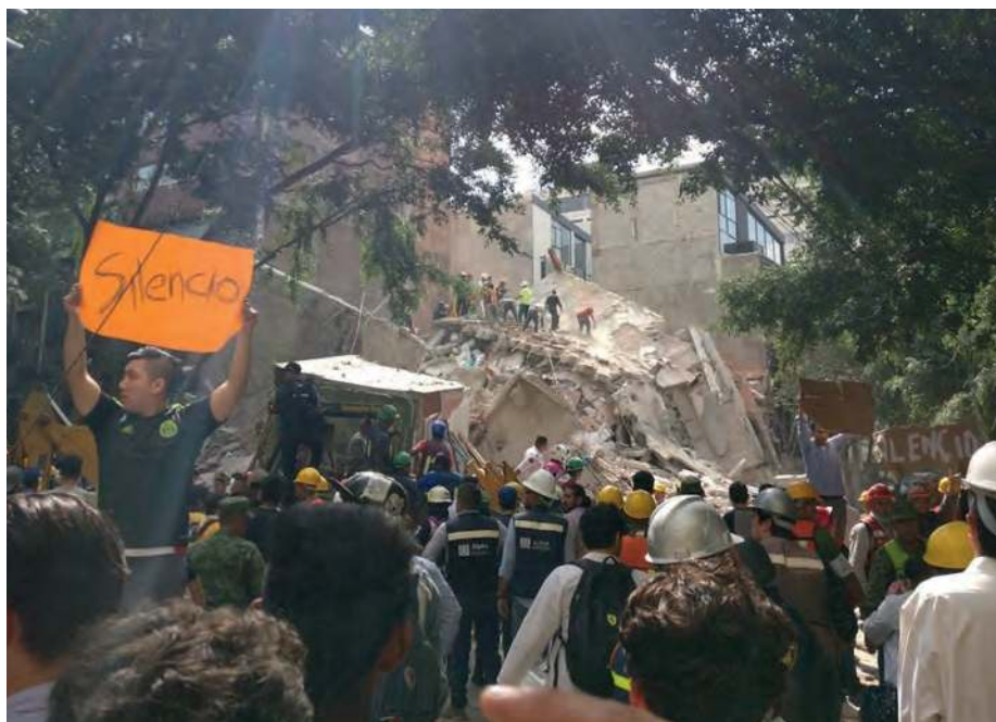
Figura 1.82 Derrumbes en la Ciudad de México después del sismo del 19 de septiembre de 2017.
