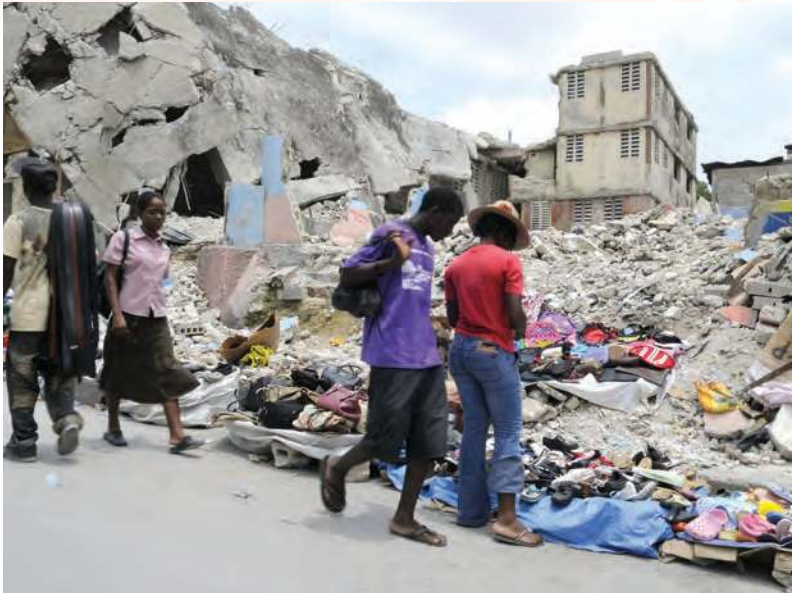
Figura 1.81 Haití, tras el sismo del 12 de enero de 2010.
