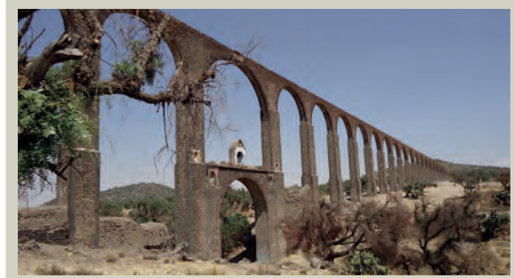
› Acueducto del Padre Tembleque, entre Hidalgo y el Estado de México
