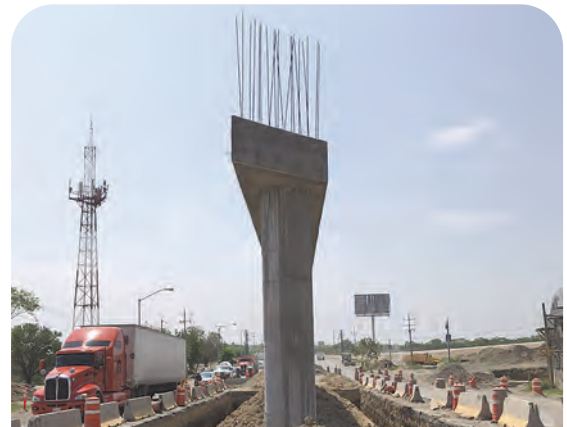
Construcción de libramiento en Benito Juárez.
