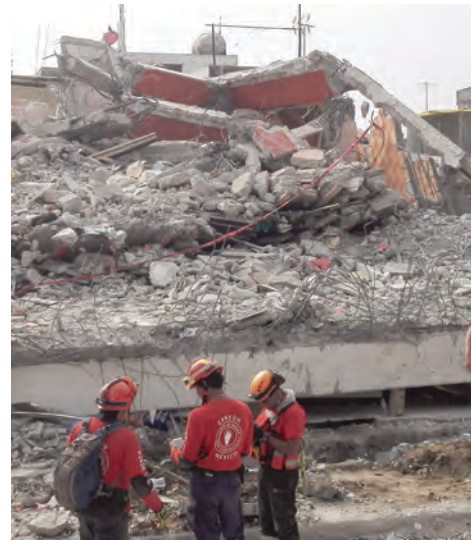
› Edificios colapsados por terremoto. Ciudad de México (2017)
