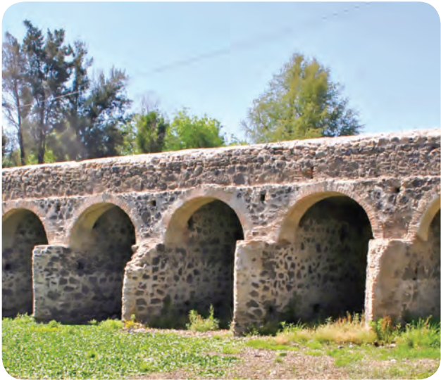
Puente del diablo, Camino Real Tierra Adentro
