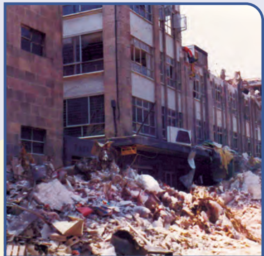
► Derrumbe de un edificio por terremoto, calzada de Talpan (1985)
