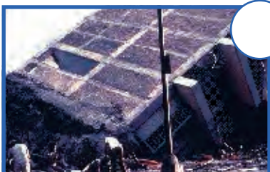
➤ Derrumbe de edificio por un terremoto en la Ciudad de México
