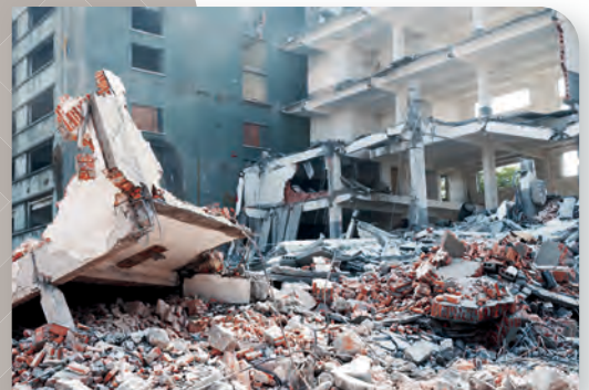
► Derrumbes en la Ciudad de México
