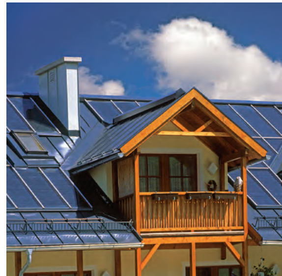
◆ Paneles solares en Viena, Austria.
