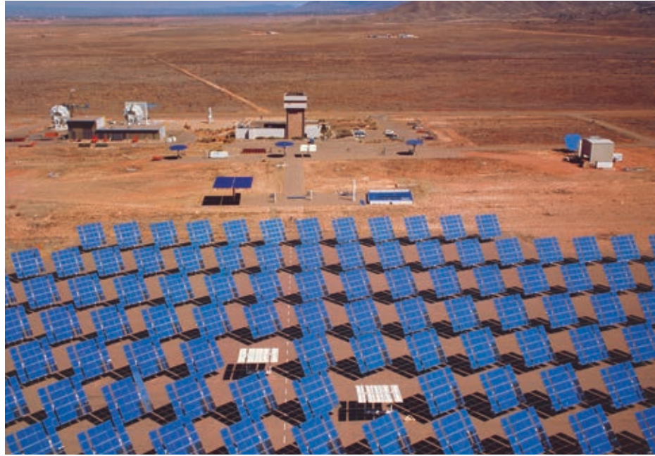
Los espejos concentran la luz solar para generar electricidad.
