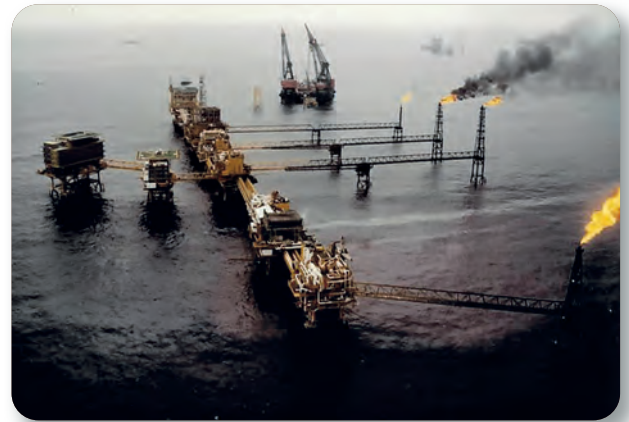
Figura 3.20 El complejo de Cantarell en la sonda de Campeche, en las aguas del golfo de México, es un conjunto de plataformas de extracción de petróleo. Actualmente, sólo produce 82 000 barriles diarios. Plataforma petrolera.
