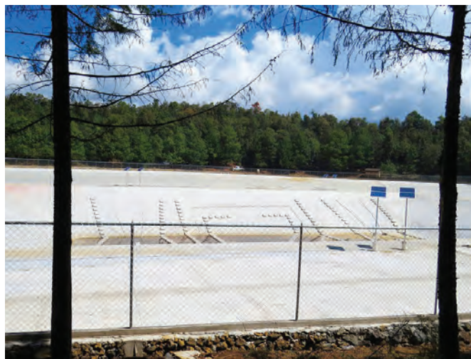
Figura 3.31 Colector pluvial en Cherán, Michoacán.
