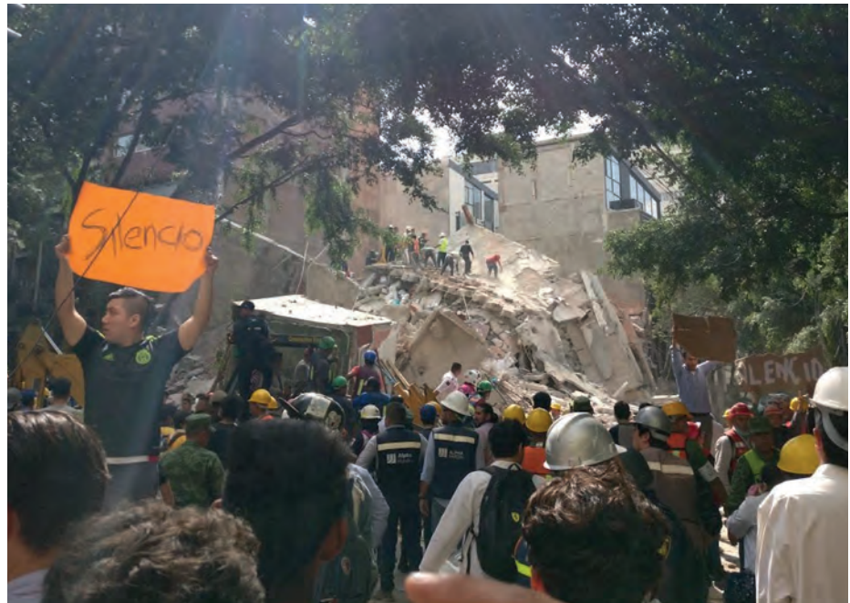
Figura 1.82 Derrumbes en la Ciudad de México después del sismo del 19 de septiembre de 2017.
