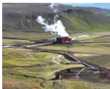
Figura 2.59 En una biorrefinería, el vapor producido al calentar agua aporta la energía cinética requerida para el funcionamiento de un generador de electricidad.
