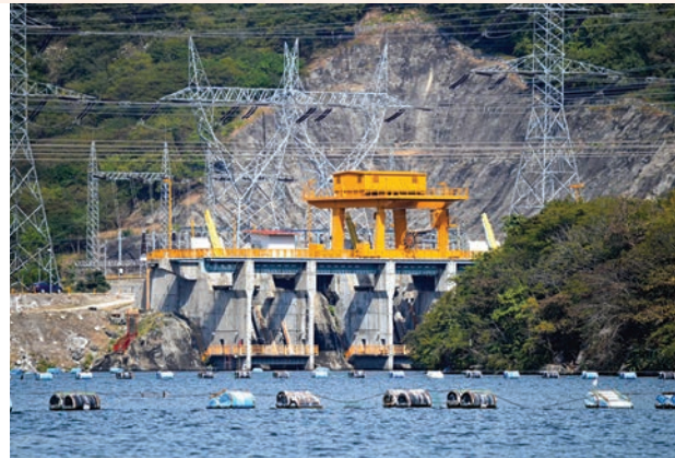
La presa de Chicoasén, ubicada en el pueblo del mismo nombre.
