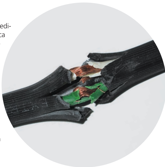
Figura 2.14 Es importante revisar periódicamente los cables de la casa para detectar y reparar este tipo de averías.
