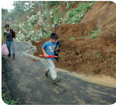
Deslaves y derrumbes en la carretera de la sierra de Misantla (Veracruz)
