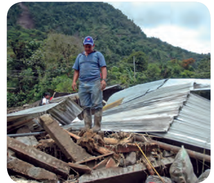
Daños ocasionados por un temblor en la ciudad de Veracruz
