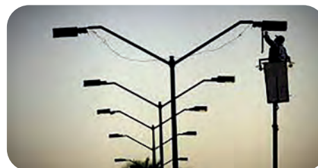
Reparación de alumbrado, Tuxpan (Veracruz)
