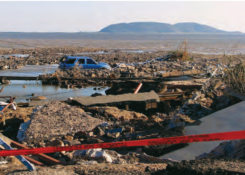
➤ Puente Douglas de Empalme, Sonora, después del huracán Jimena en 2009
