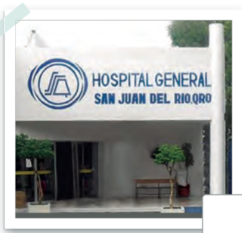
> Hospital General de San Juan del Río (1996)
