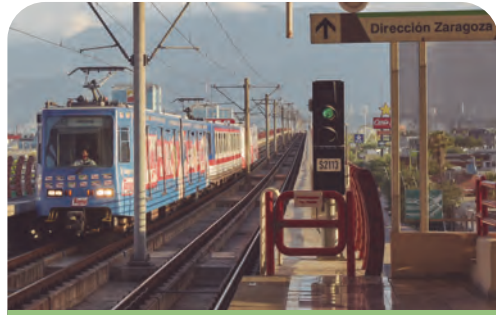
Estación del metro en Monterrey (2020)
