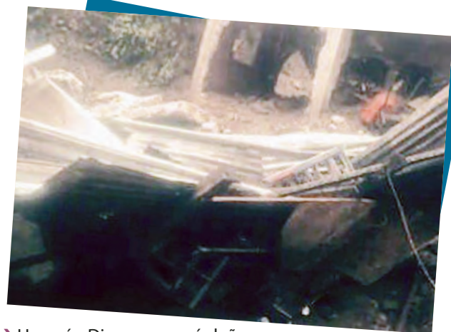
› Huracán Diana provocó daños en la ciudad de Huejutla de Reyes (1990)
