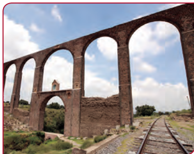
■ Acueducto del Padre Tembleque
