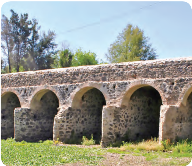
Puente del diablo, Camino Real Tierra Adentro
