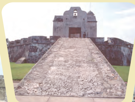
Baluarte de Santiago, ubicado en el centro de Veracruz (1635)
