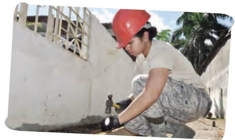
Trabajadora de la construcción
