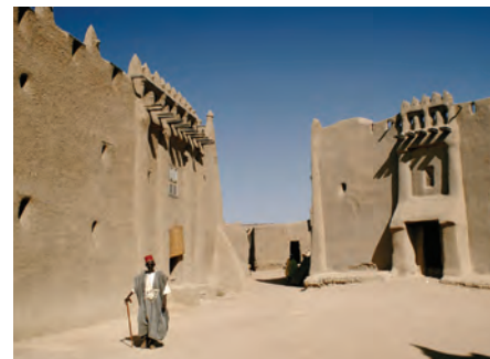
❖ Arquitectura de la ciudad de Djenné, en el delta interior del río Níger, Malí.
