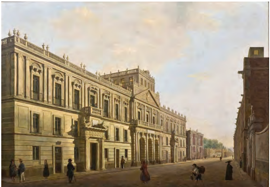
Figura 3.6 El Colegio de Minería fue construido entre 1797 y 1813 con los planos y la dirección de Manuel Tolsá, para albergar al Real Tribunal de la Minería. El Palacio de Minería . Pedro Gualdi (1840).
