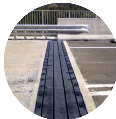
Figura 1.80 Para evitar que algunos puentes se deformen o se rompan, se colocan separaciones entre los bloques que los conforman.
