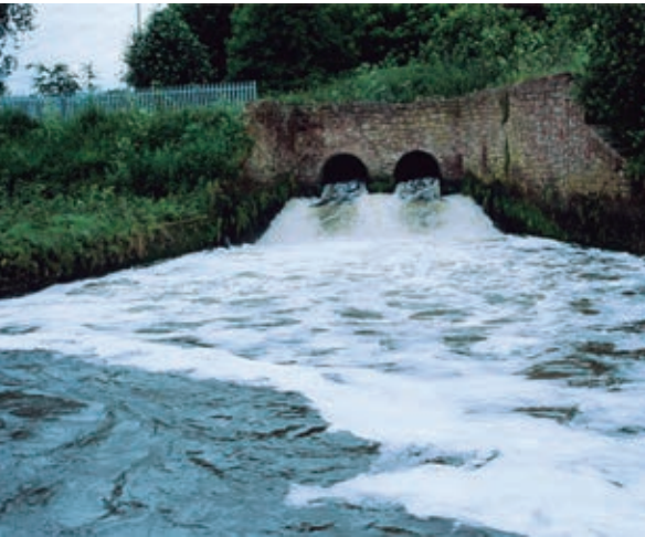
Agua contaminada. Los detergentes que se incorporan fácilmente al ambiente producen menos espuma.
