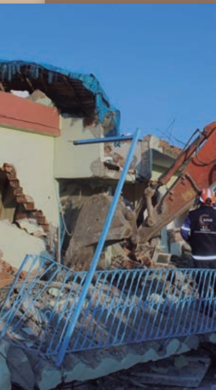
Comercio dañado por terremoto en Capadocia, Turquía.
