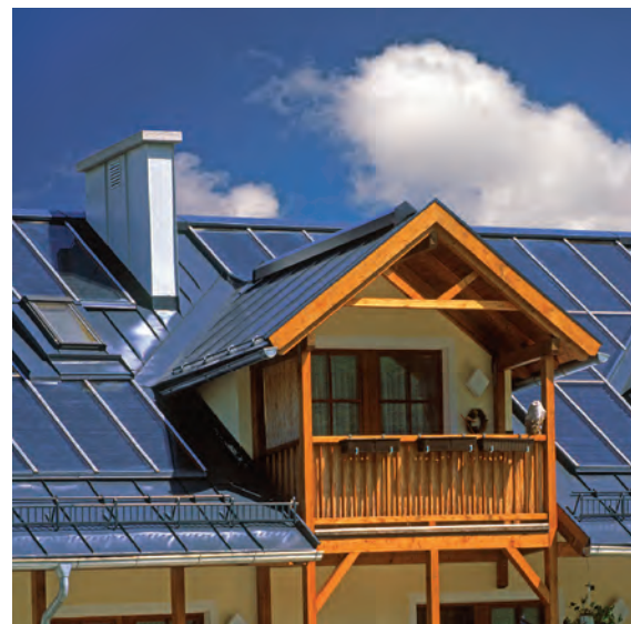
◆ Paneles solares en Viena, Austria.
