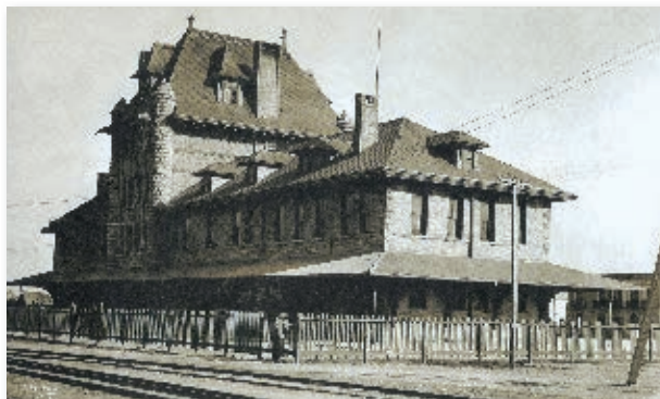
Estación del Golfo en Monterrey.
