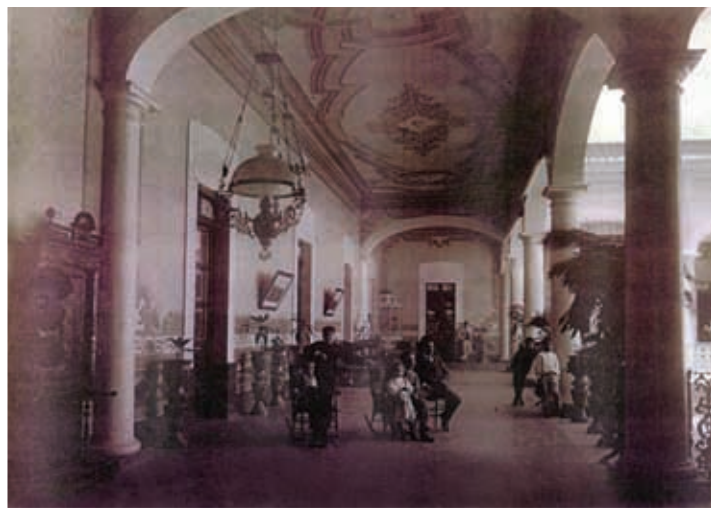
Interior de la Casa Aguirre.
