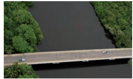
Puente en zona de manglares.
