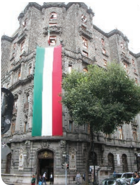
➤ Edificio de la Biblioteca de la Suprema Corte de Justicia, en la esquina de las calles Bolívar y 16 de Septiembre.
