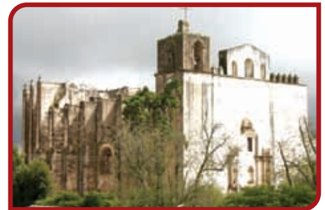
Iglesia y convento de Atotonilco el Grande.
