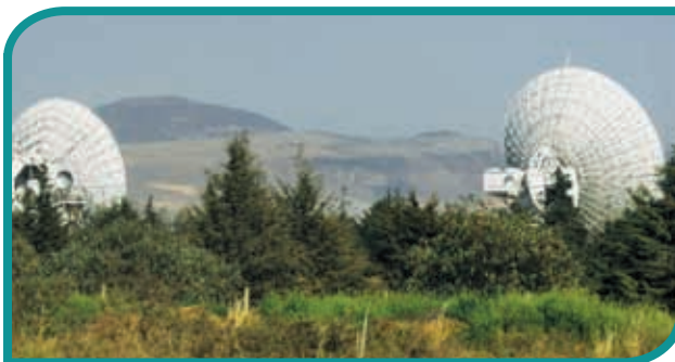
Estación Terrena de Telecomunicaciones.
