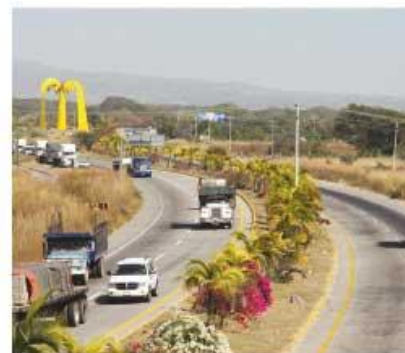
Carretera de cuatro carriles Colima-Guadalajara. Es la principal vía de comunicación terrestre; facilita el ingreso de personas y productos diversos a distintos puntos del estado.
