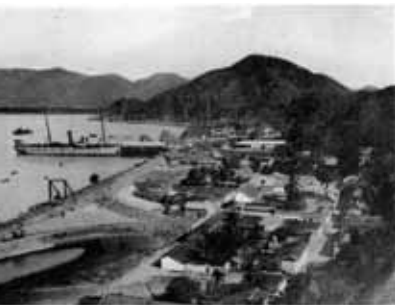
Las obras de ampliación del puerto de Manzanillo en 1909.
