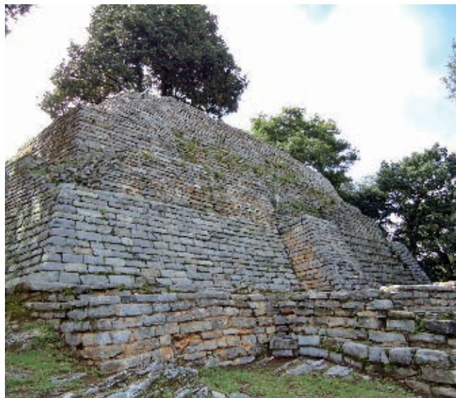
En lo alto de las lomas, los habitantes de Ranas levantaron edificaciones como ésta.
