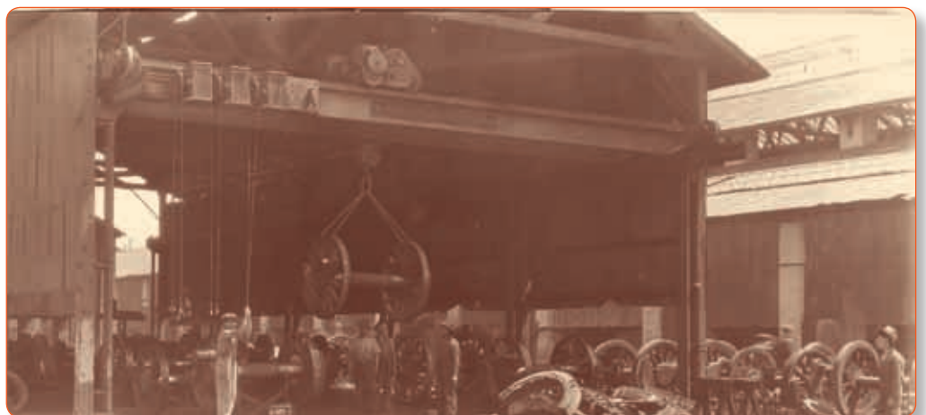
Grúa eléctrica móvil en los talleres de ferrocarril de Aguascalientes.
