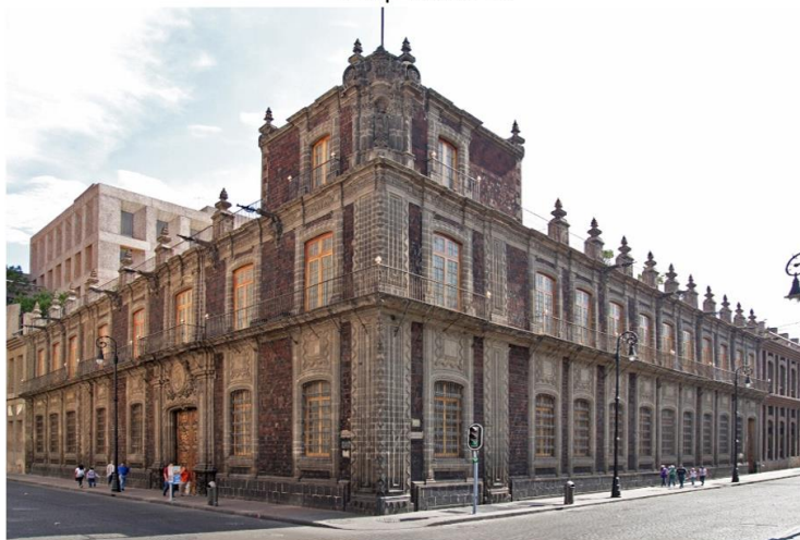
Palacio de los condes de San Mateo de Valparaíso.
