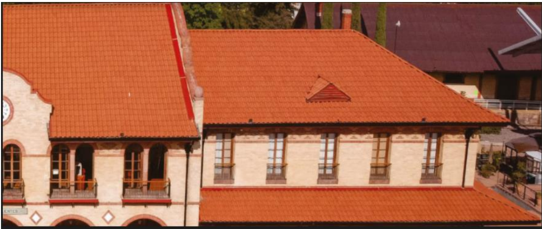
Teselado de techo y ventanas.
