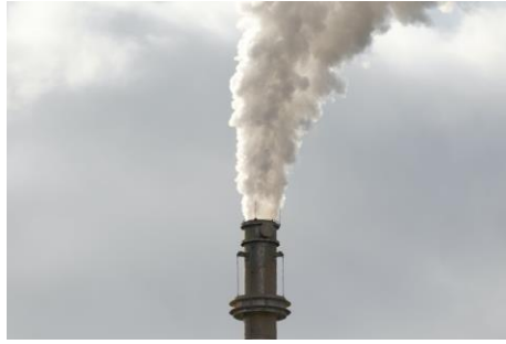
Emisión de gases con efecto invernadero en una fábrica.
