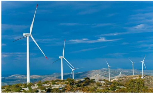
Energía eólica, en Oaxaca, México.
